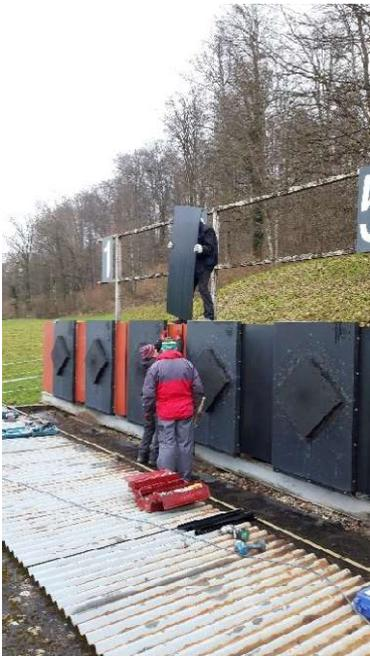
Verkleidung der Hardox® 500 Stahlplatten mit schwarzen PVC-Platten
