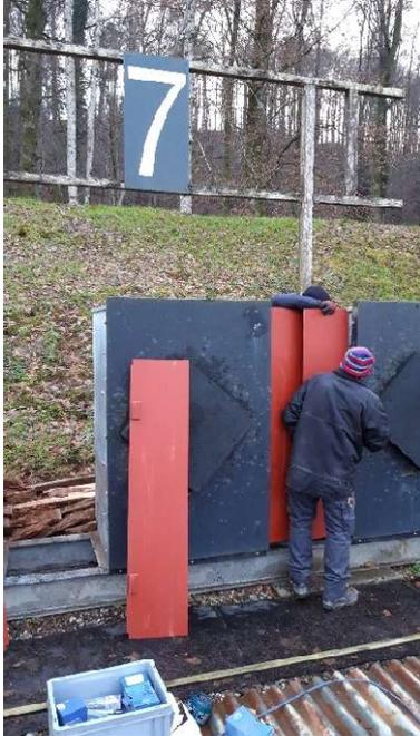
Einbau der 6 mm Hardox® 500 Stahlplatten zwischen den Kugelfangkästen
